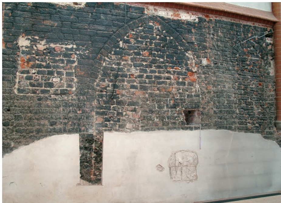
1 Freigelegte Wandfläche an der Nordwand mit verschlossenen Nischen.
