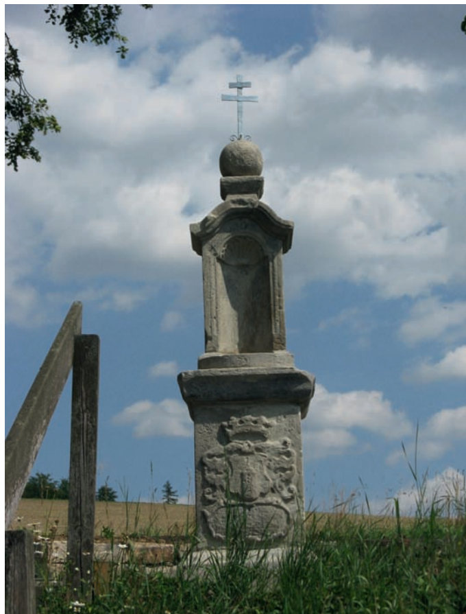
4 Flurstation in Winzenburg, Ldkr. Hildesheim, nach der Restaurierung 2010.
